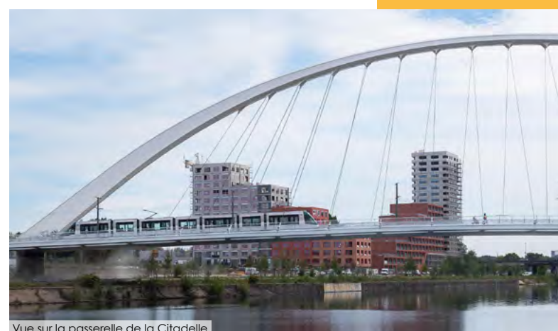
Vue sur la passerelle de la Citadelle
