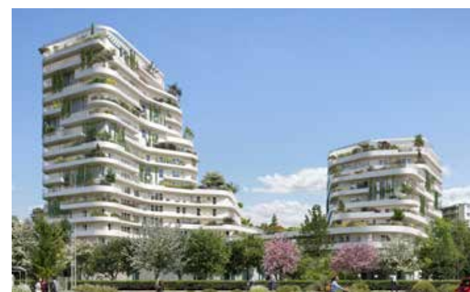
Harmony of the Sky - Saint-Nazaire Architecte : Hamonic & Masson
