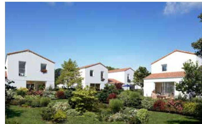
Le Bois Valentin - Saint-Jean-de-Monts Architecte : Agence d'architecture ACDM
