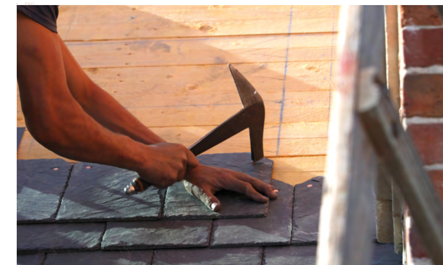
Pose des ardoises au clou au Domaine de Bonnelles, technique traditionnelle de restauration réservée aux Monuments Historiques.
