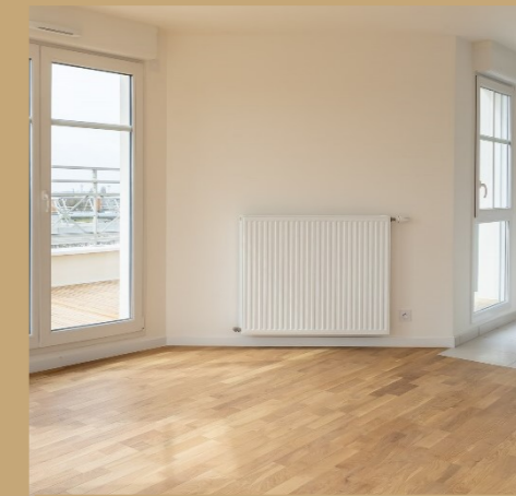
Chauffage économe en énergie
