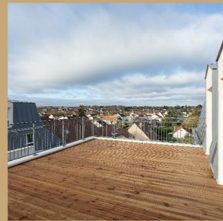
Terrasses ou balcons bois
