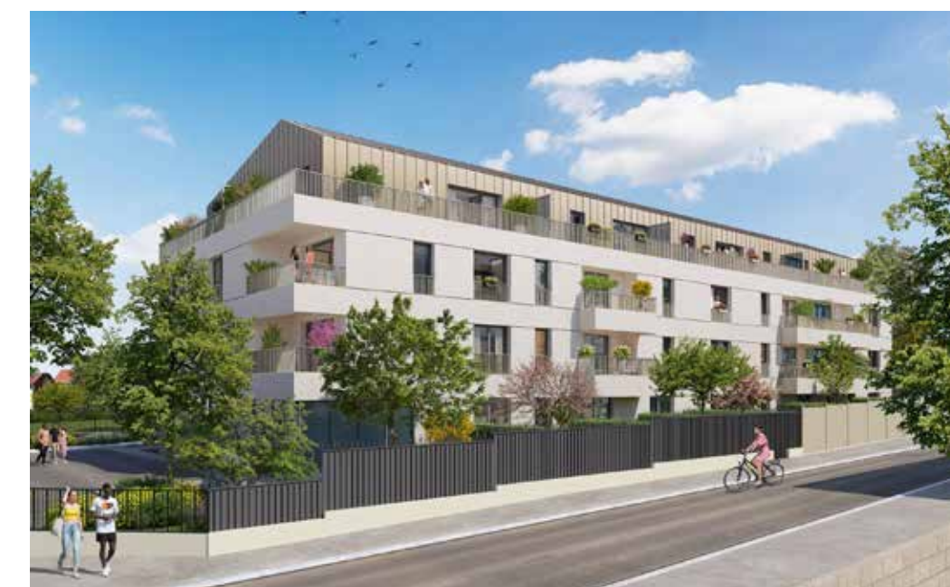
Résidence Le Coty à Ambarès-et-Lagrave Architecte : Agence M2L Architectes
