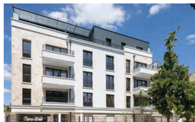
Villa Flora - Fontenay-sous-Bois Architecte : A2D Architecture
