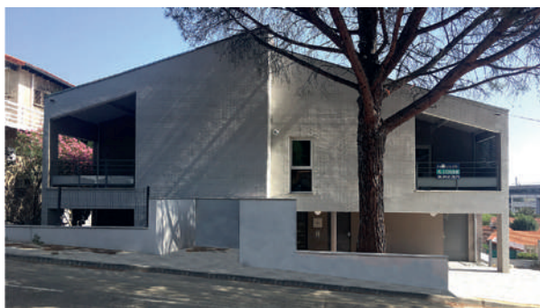
APORIA, Colomiers 7 logements collectifs - Livraison 2019
