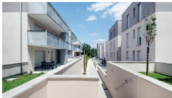
AERIANA, Cugnaux 45 appartements - livraison 2021
