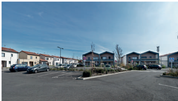
COTTAGE TOLOSA, Labège (AMO) 48 logements collectifs et 17 villas - Livraison 2019
