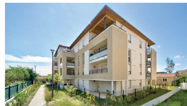
HARMONIA, Mondonville 42 appartements - livraison 2020
